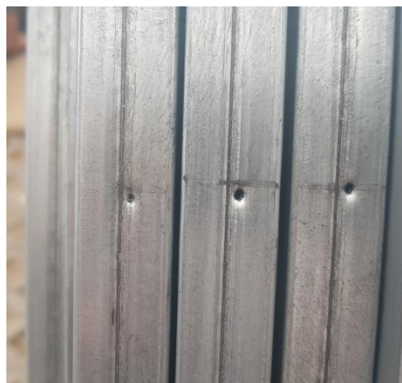
Pripravené otvory na skrutky
